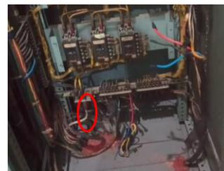
Gambar 17. Penunjukan letak *wiring* *rectifier* trafo
