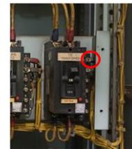
Gambar 9. Penunjukan letak MCB TIE Transformer wiring visual
