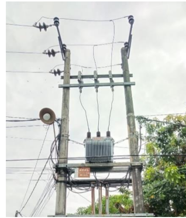
Gambar 3. Konstruksi pemasangan LA sebelum FCO di ULP Daya
