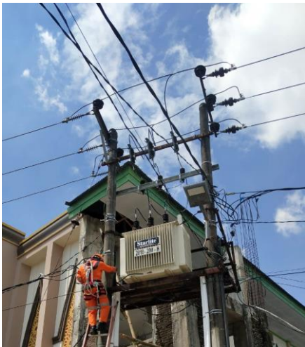
Gambar 5. onstruksi pemasangan LA Setelah FCO di ULP Daya
