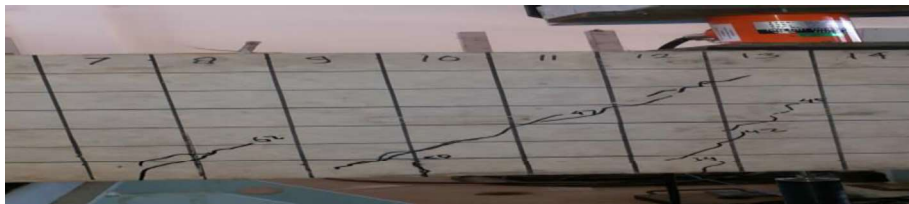
Gambar 6. Pola retak geser balok normal ( tanpa perkuatan geser GFRP)
