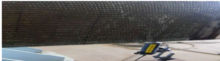
Gambar 5. Balok beton perkuatan geser GFRP berbentuk U tegak menerus
