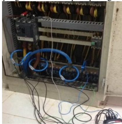
Gambar 1. Instalasi kabel alat ukur pada panel distribusi
