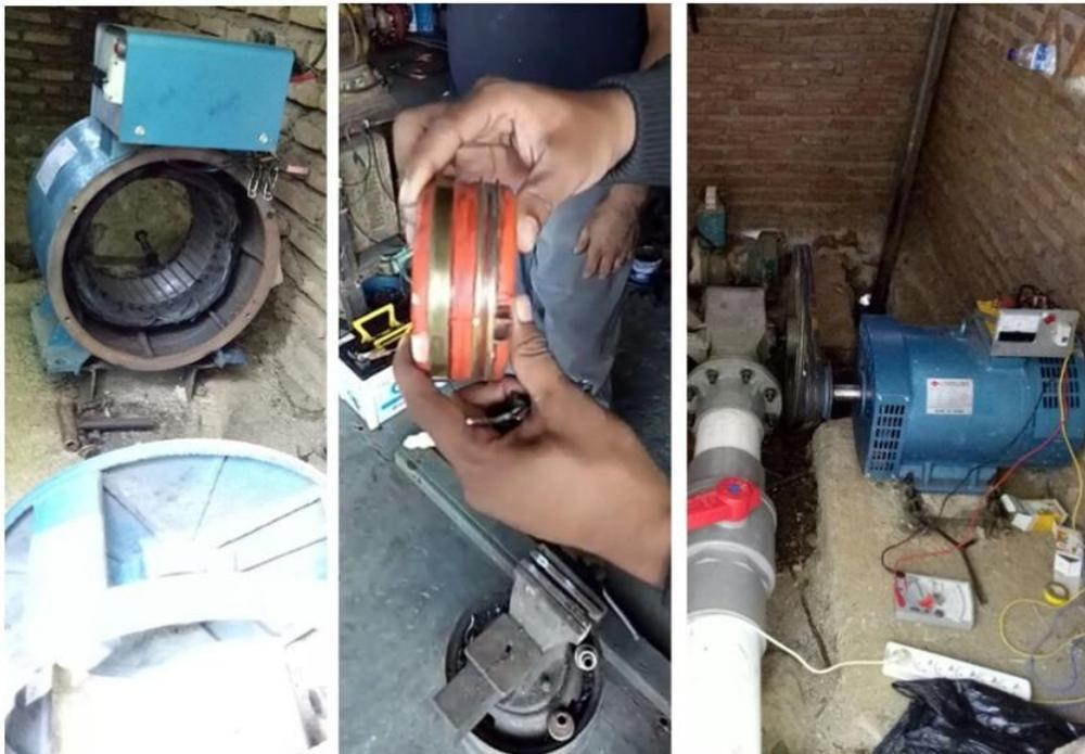
Gambar 2. Generator dalam proses perbaikan dan setelah pemasangan kembali
