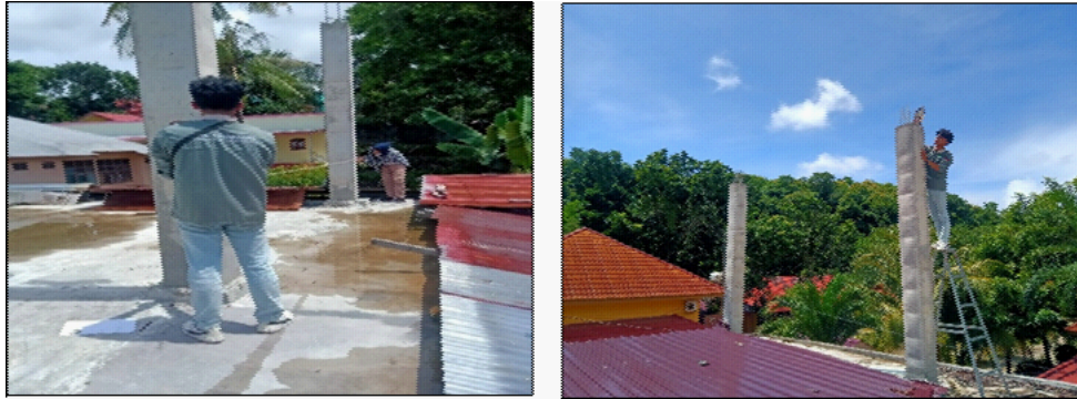
Gambar 3. Kegiatan survey lapangan dan pengukuran eksisting bangunan masjid
