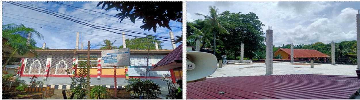
Gambar 1. Kondisi eksisting Masjid Nurul Ilmi SMA Negeri 5 Parepare
