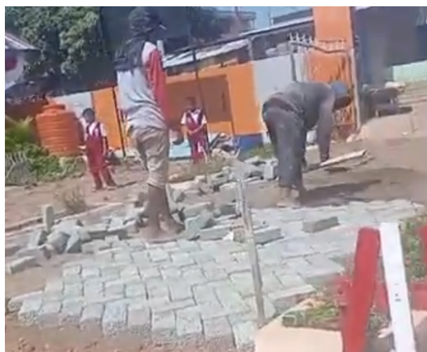
Gambar 5. Pekerjaan pemasangan paving block
