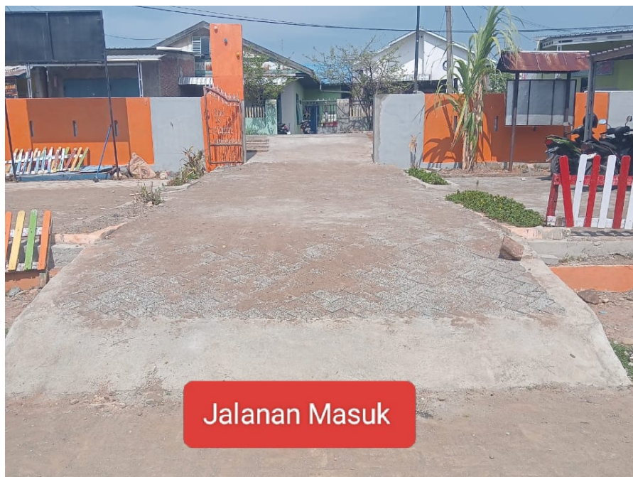
Gambar 6. Paving Block yang Telah Terpasang di Jalan Masuk Sekolah
