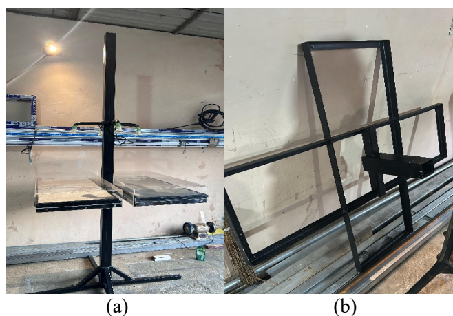
Gambar 3. Proses Instalasi dan Pengadaan Sistem (a) Pemasangan Rangka (b) Pemasangan rangka PLTS
