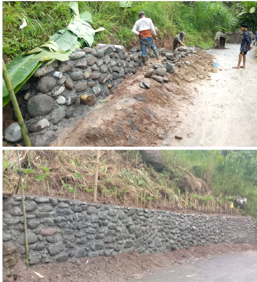
Gambar 5. Prototipe dinding penahan tanah tipe gravitasi yang telah dikonstruksi.
