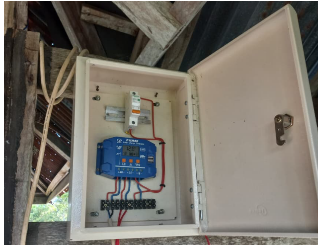
Gambar 5. Hasil Rangkaian Komponen PLTS
