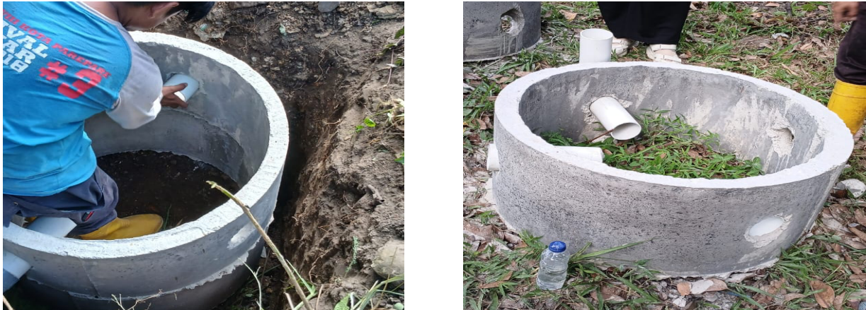
Gambar 4. Hasil pekerjaan Sumur Resapan
