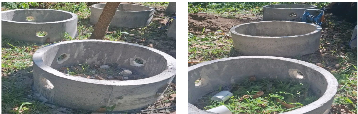
Gambar 3. Proses Pemasangan Sumur Resapan
