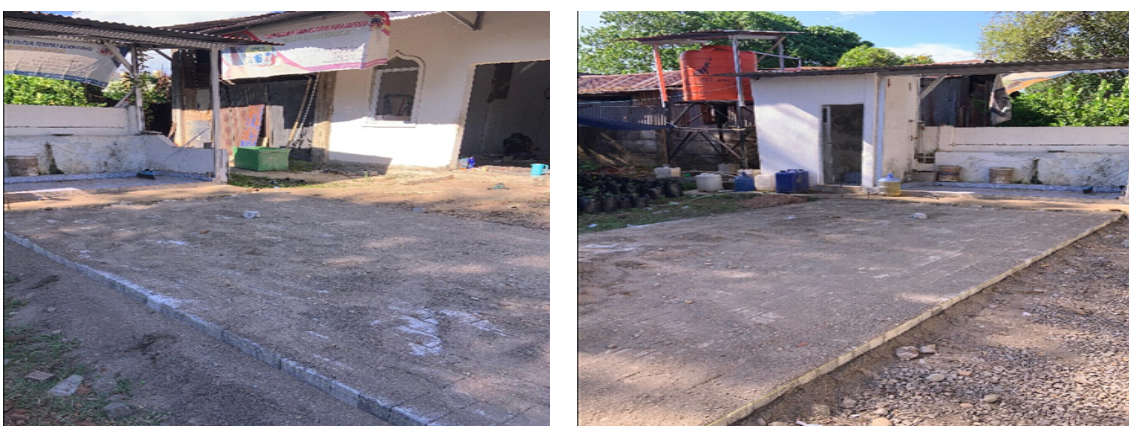
Gambar 3. Finishing Pemasangan Paving Blok
