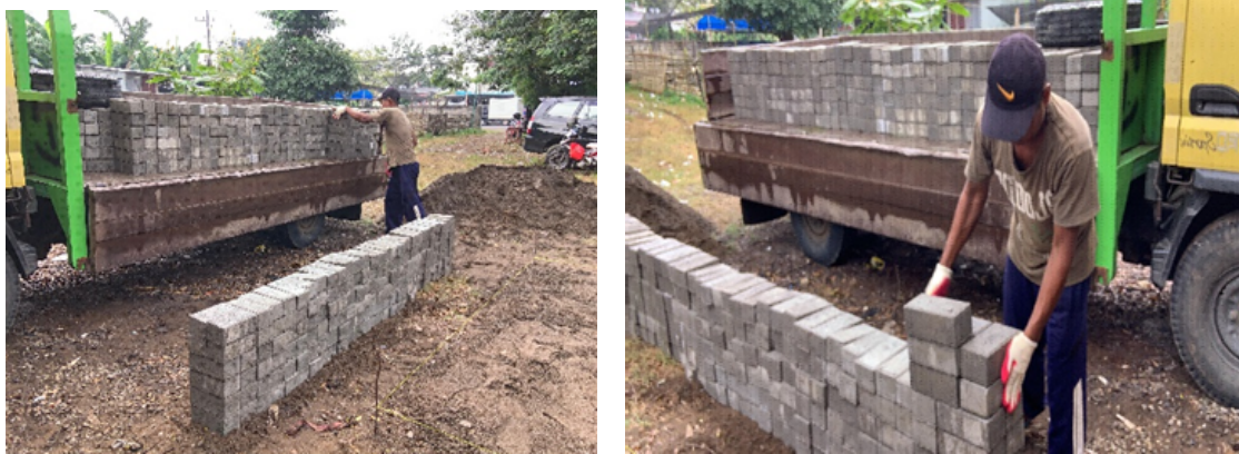
Gambar 1. Persiapan Material Paving Blok di Lokasi Pengabdian
