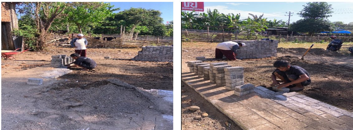
Gambar 2. Proses Pemasangan Paving Blok
