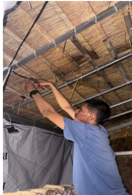
(a) Pemasangan Nozzle
