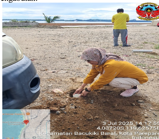
Gambar 1. Pemasangan Sumur Biopori
