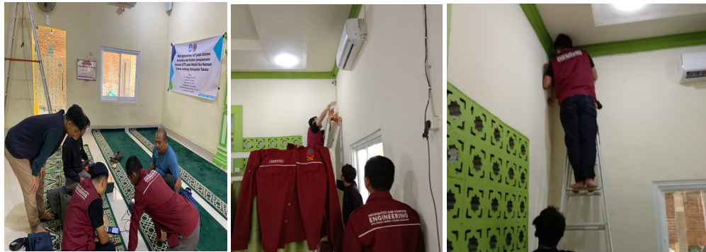
Gambar 5. Pemasangan Instalasi IoT dan CCTV
