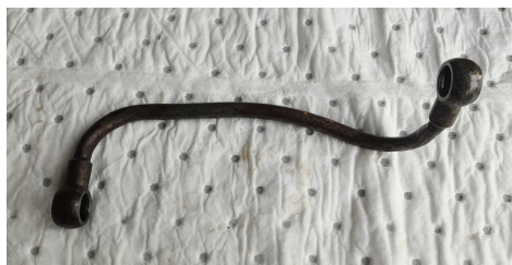
Gambar 9. Visual Inspection pada Pipe
