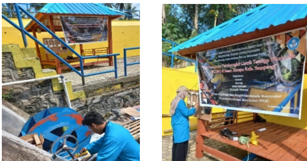
Gambar 2. Pemasangan turbin roda air dan lampu penerangan di lokasi
