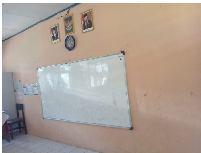
Gambar 3. Hasil akhir pekerjaan acian dan pengecatan
