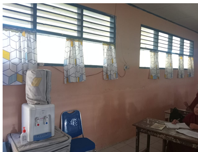
Gambar 2. Perkembangan pekerjaan acian dan pengecatan di ruang kelas
