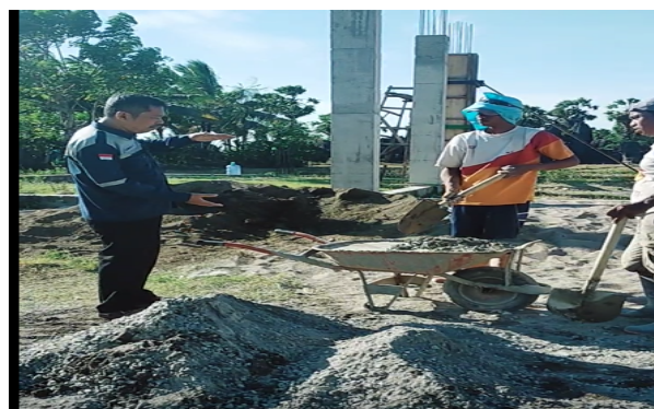
Gambar 4. Pembuatan beton tangki septik
