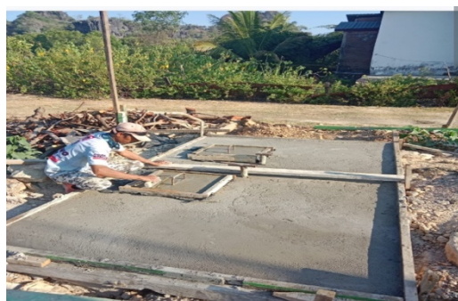
Gambar 9. Finishing pengecoran tangki septik
