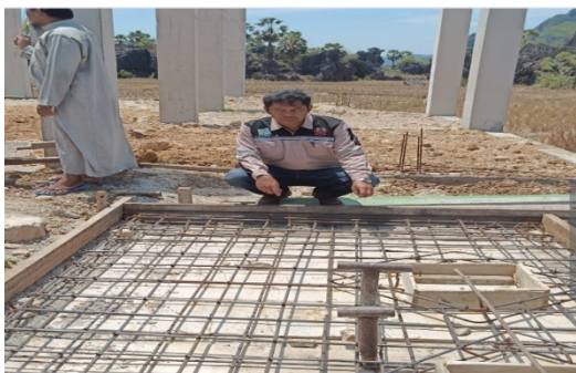
Gambar 7. Pemeriksaan tulangan tangki septik
