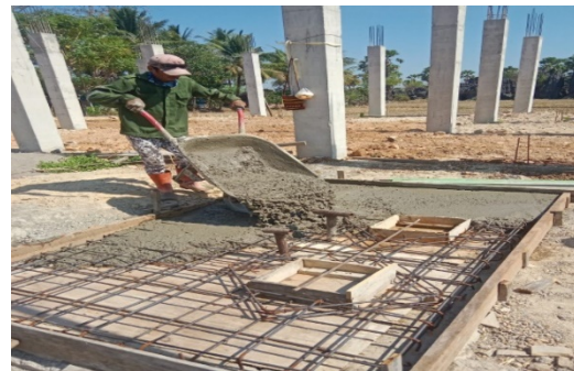
Gambar 8. Pengecoran penutup tangki septik
