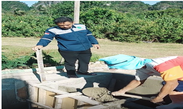
Gambar 5. Pengecoran tangki septik
