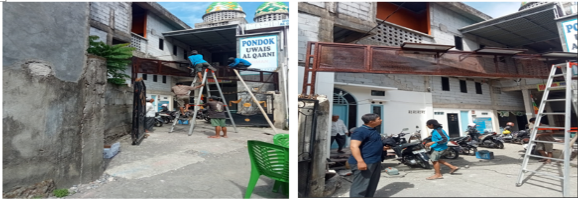
Gambar 5. Pemasangan Rangka Gerbang Dan sejumlah 3 Panel Sel Surya
