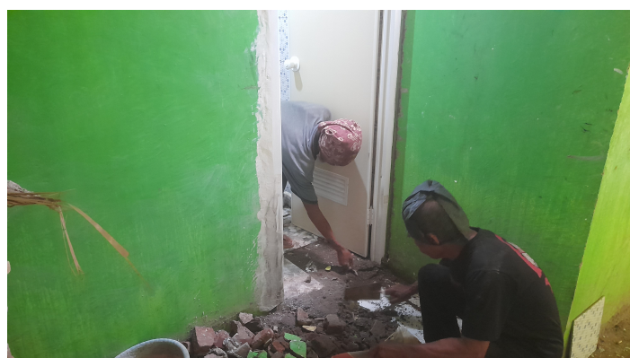
Gambar 2. Pemasangan pintu dan finishing lantai wc
