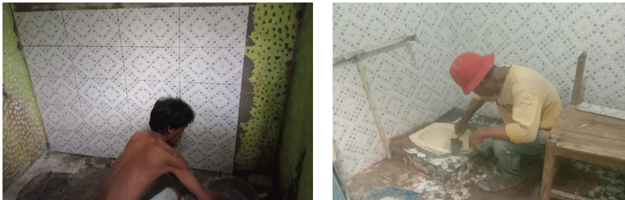
Gambar 1. Pelaksanaan pemasangan pelapis dinding wc dan kloset jongkok
