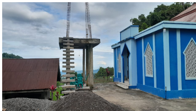
Gambar 4. Hasil Pekerjaan Pembetonan Tangga
