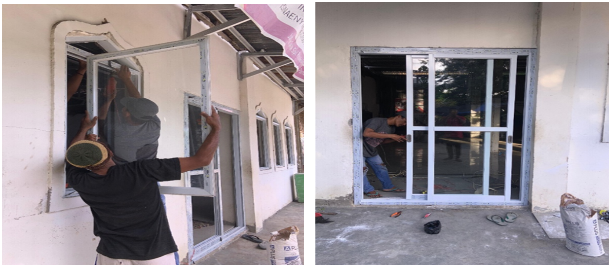
Gambar 3. Proses Pemasangan Pintu dan Jendela
