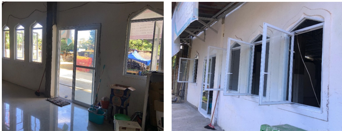
Gambar 4. Hasil Pemasangan Pintu dan Jendela
