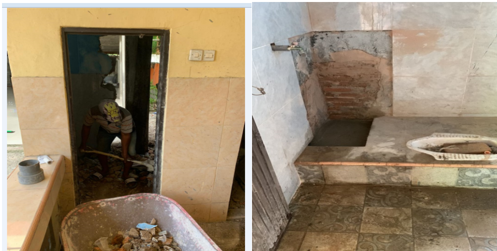
Gambar 2. Kondisi saat pengerjaan toilet
