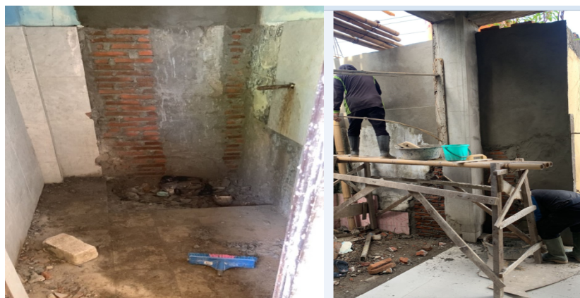
Gambar 3. Perbaikan Plasteran, Kramik Dinding dan Lantai
