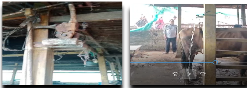
Gambar 4. Penyambungan Instalasi Listrik Pompa Air dan Pengujian Operasi
