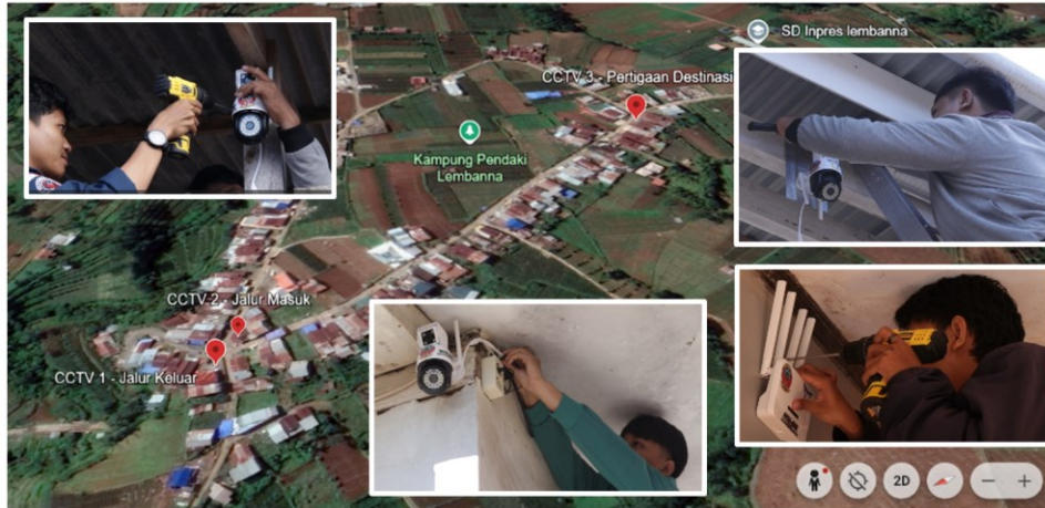
Gambar 5. Pemasangan perangkat CCTV pada setiap spot lokasi oleh Tim PKM
