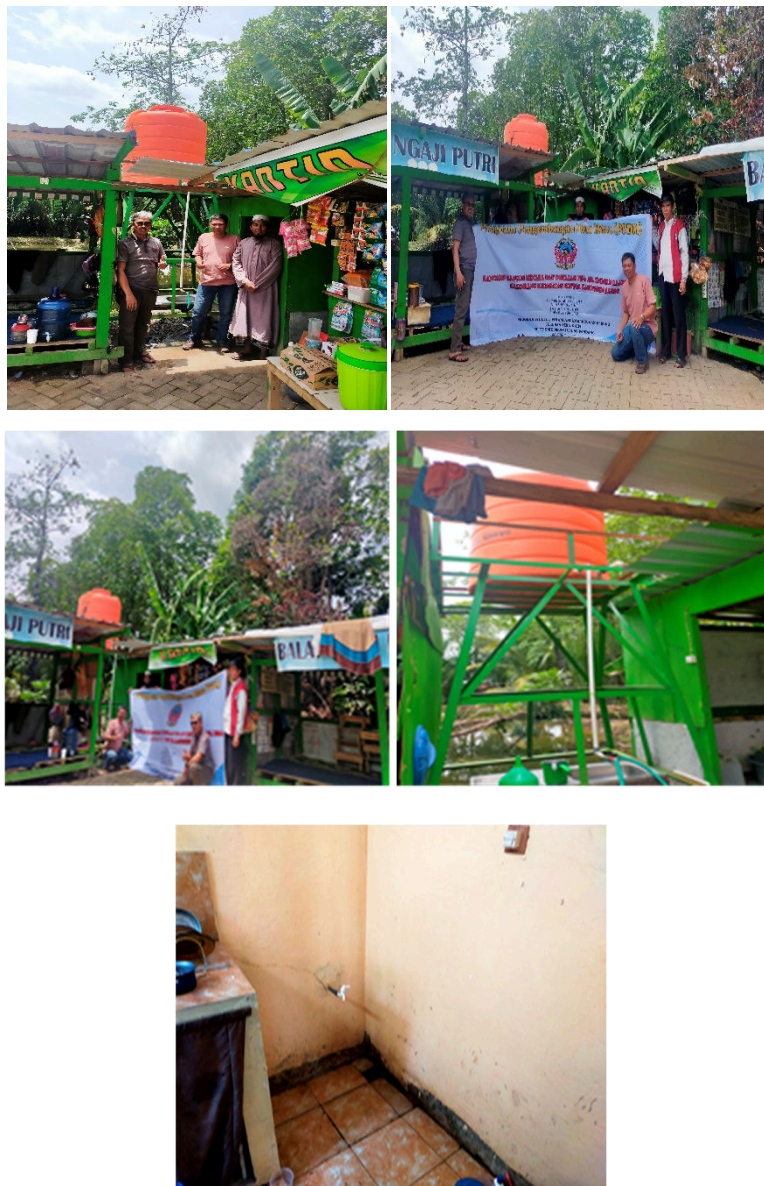
Gambar 3. Kondisi bak penampung air dan instalasi pipa sesudah kegiatan
