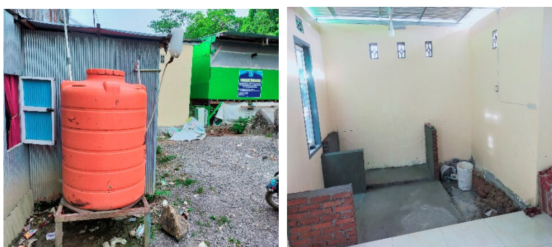
Gambar 1. Kondisi bak penampung air dan instalasi pipa sebelum kegiatan
