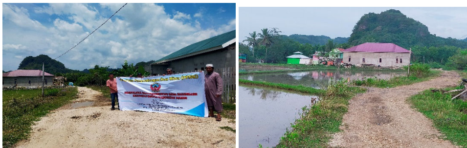
Gambar 5 Kondisi jalan penghubung yang telah diratakan.
