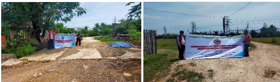
Gambar 6 Kondisi jalan penghubung yang telah diberi perkerasan/ditingkatkan
