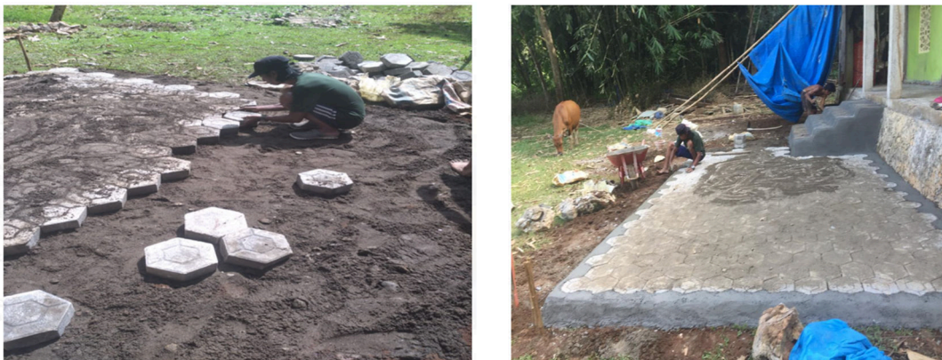
Gambar 3. Pengerjaan teras mushallah dengan pemasangan paving block
