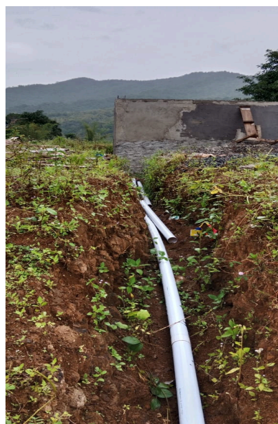
Gambar 4. Pemasangan pipa jaring distribusi air bersih
