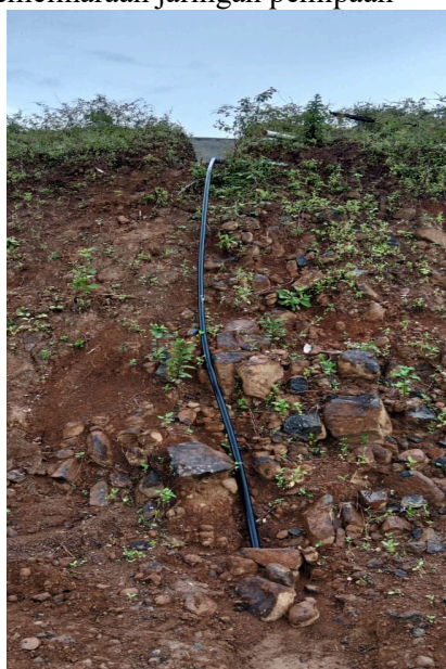
Gambar 4. Pemasangan pipa jaring distribusi air bersih
