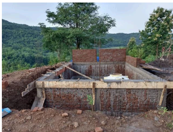
Gambar 3. Bak penampungan air untuk distribusi yang sedang dibangun
