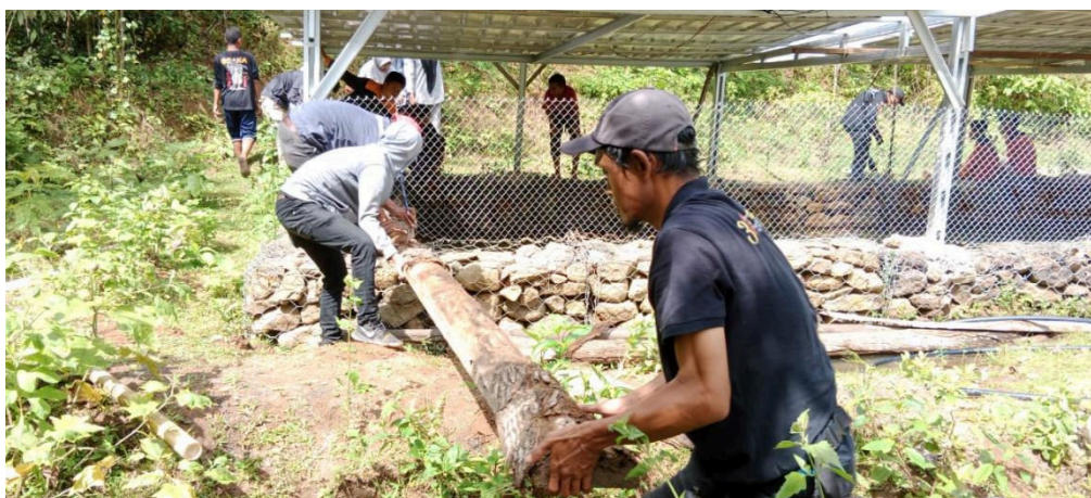
Gambar 5. Pemasangan balok landasan pompa di atas bak air
