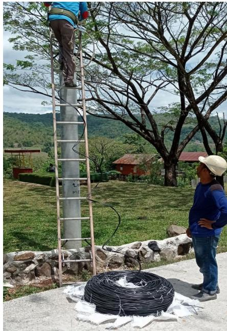
Gambar 5. Pemasangan kabel pada tiang listrik
