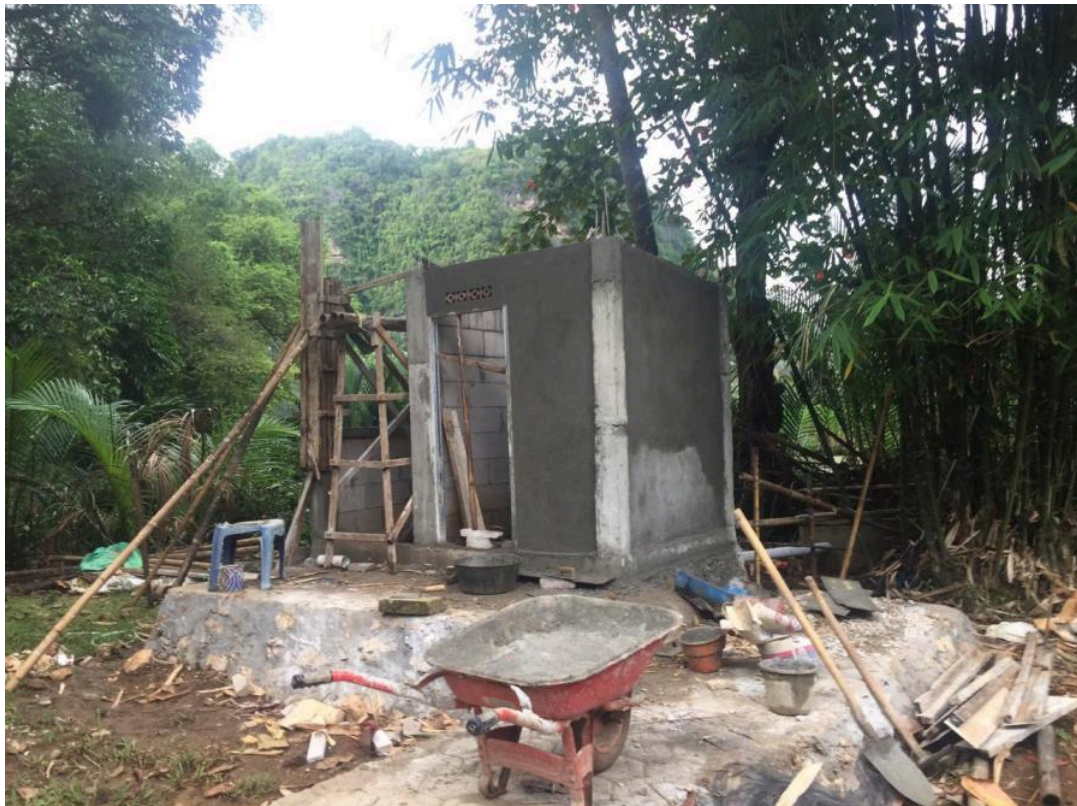
Gambar 4. Kondisi WC/KM setelah diplester
