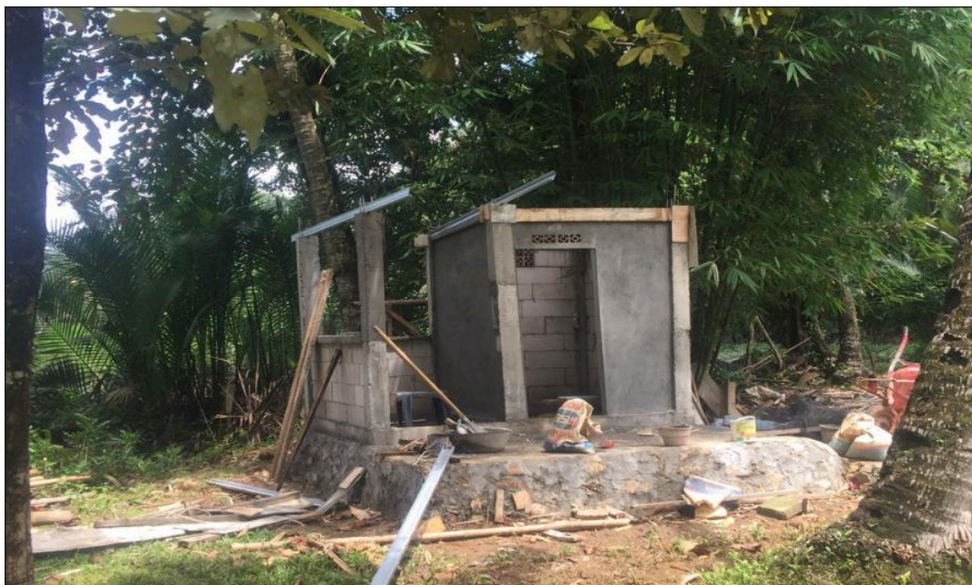
Gambar 5. Proses Acian dan Siap Untuk pengecatan
