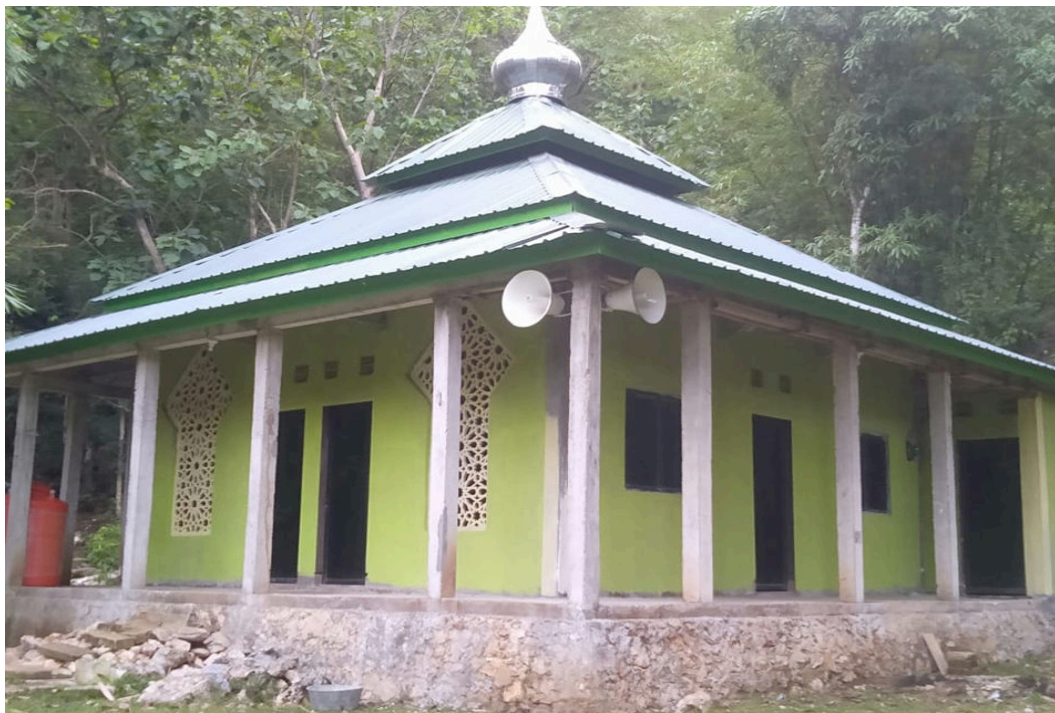
Gambar 4. Kondisi Setelah pengecatan dan pengacian
