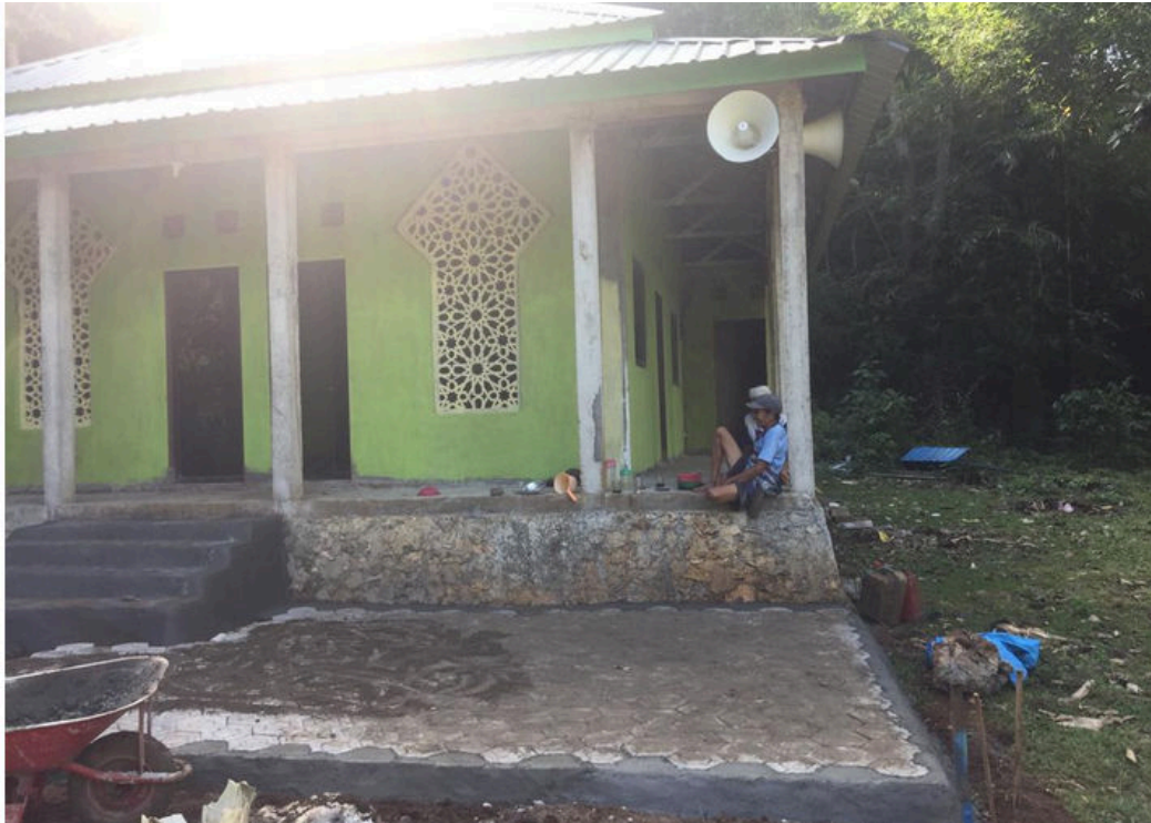
Gambar 3. Kondisi Setelah pengecatan dan pengacian
