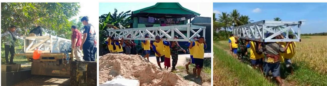
Gambar 3. Proses pengangkutan struktur rangka jembatan ke lokasi kegiatan PKM
