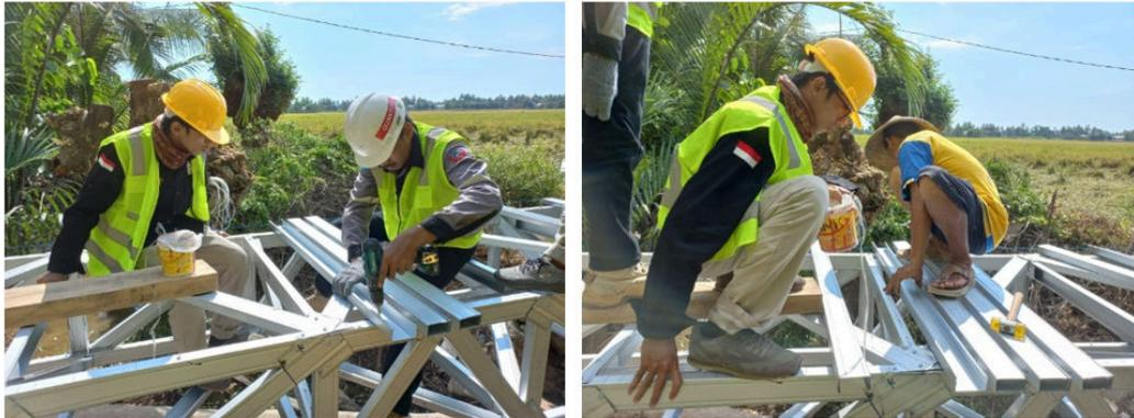
Gambar 6. Proses pemasangan lantai jembatan
