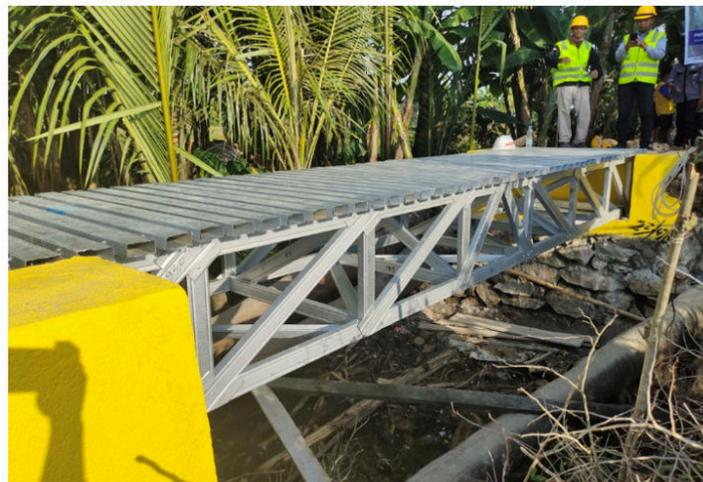
Gambar 7. Jembatan rangka baja canai dingin yang telah jadi
