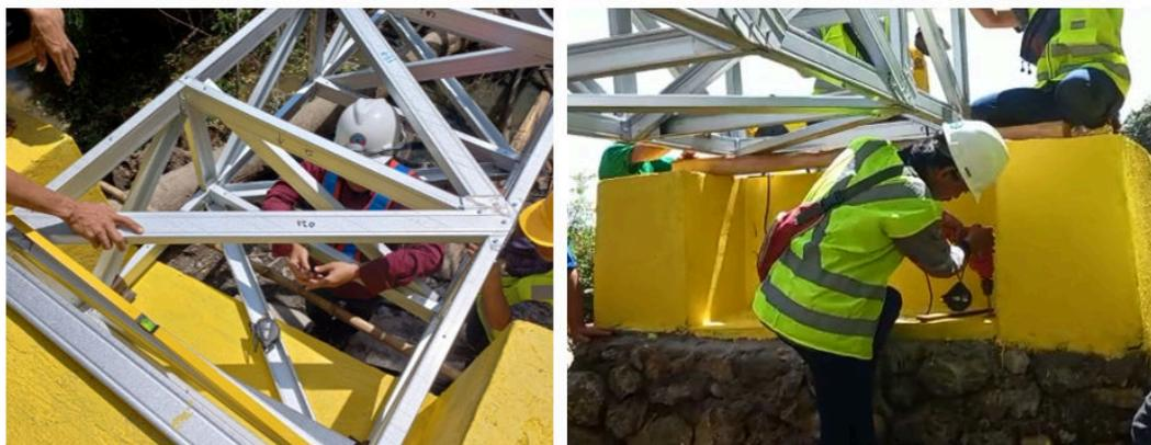
Gambar 4. Proses penyetelan posisi angkur jembatan
