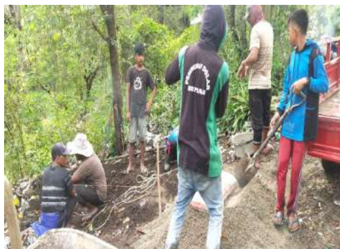
Gambar 4. Penggalian tanah untuk pondasi
