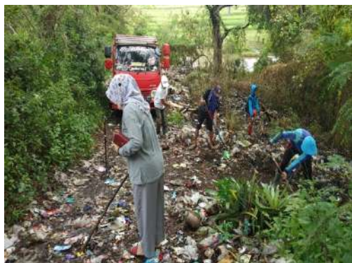
Gambar 2. Pembersihan Lokasi Pekerjaan
