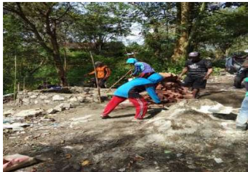
Gambar 6. Pemasangan Pondasi Batu Gunung
