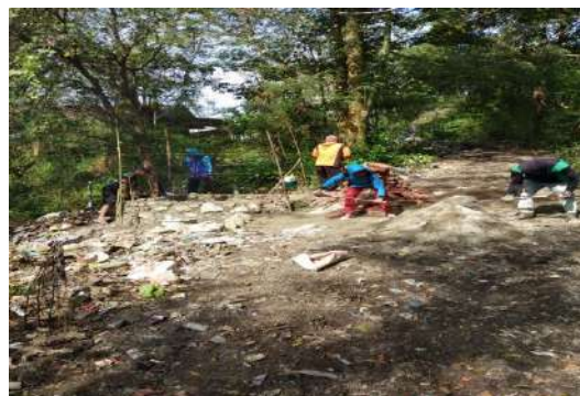
Gambar 5. Pencampuran Spesi Untuk Pemasangan Pondasi
