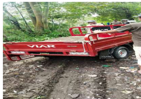
Gambar 3. Pengangkutan Material ke lokasi Pekerjaan
