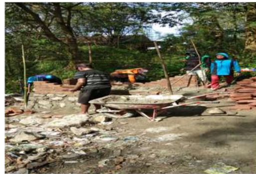
Gambar 7. Pemasangan Dinding Batu Bata
