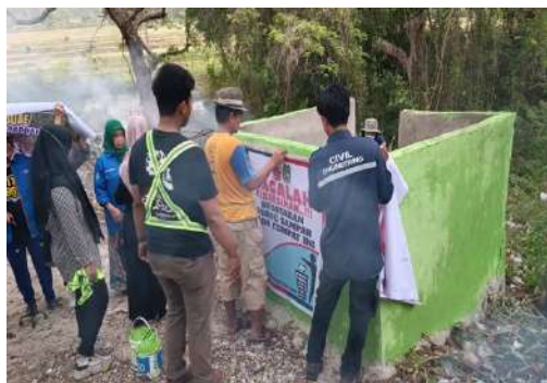
Gambar 10. Pemasangan baliho pemeliharaan
