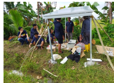
Gambar 3. Pemasangan PLTS Untuk Pembangkit Air ke Tempat Pembesaran Ikan Mas dan Nila
