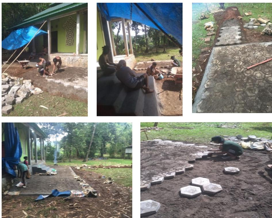
Gambar 3. Hasil Pemasangan Paving Block mulai dari land clearing, pemasangan lapisan pasir hingga pemasangan paving block
