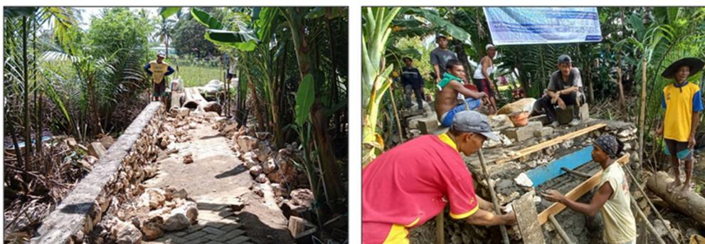
Gambar 3. Tahapan pembuatan jalan akses dan pondasi dudukan jembatan
