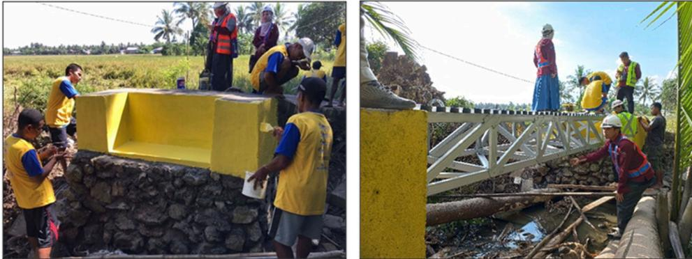
Gambar 4. Tahapan pengecatan pondasi dan pemasangan rangka jembatan
