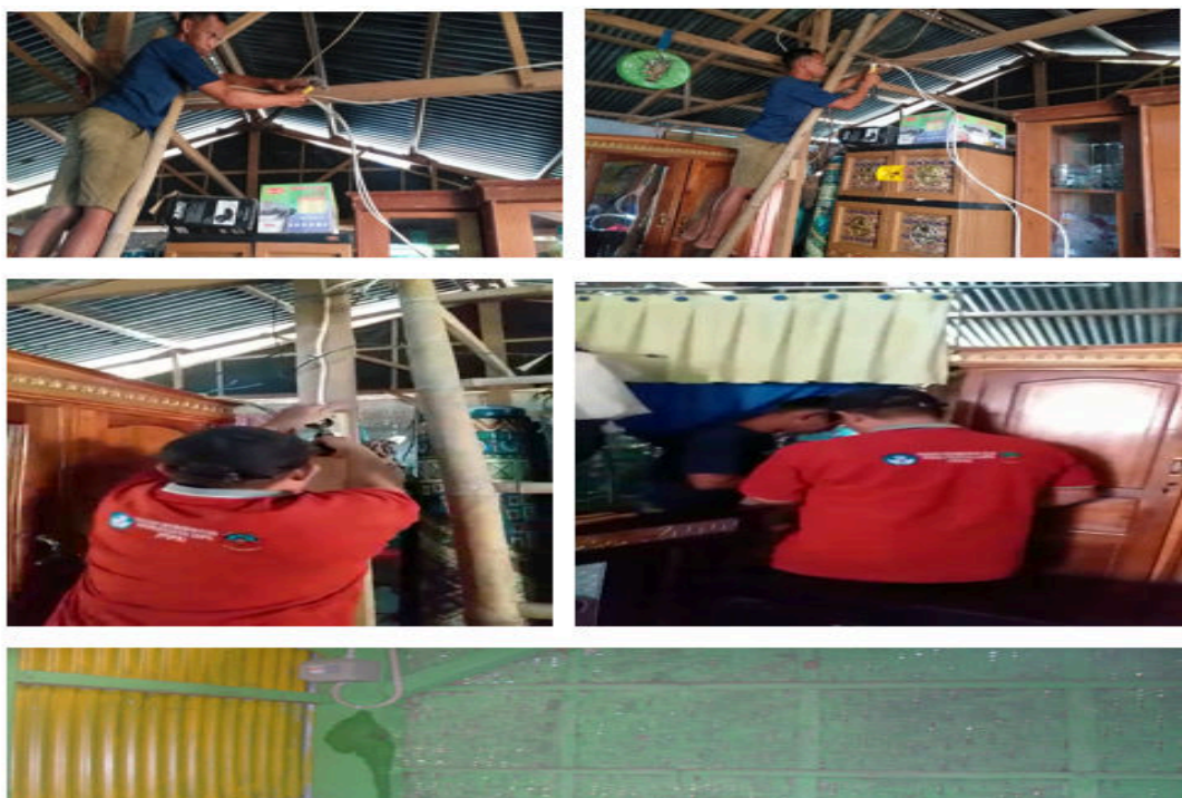
Gambar 3. Pemasangan Instalasi Listrik Penerangan
