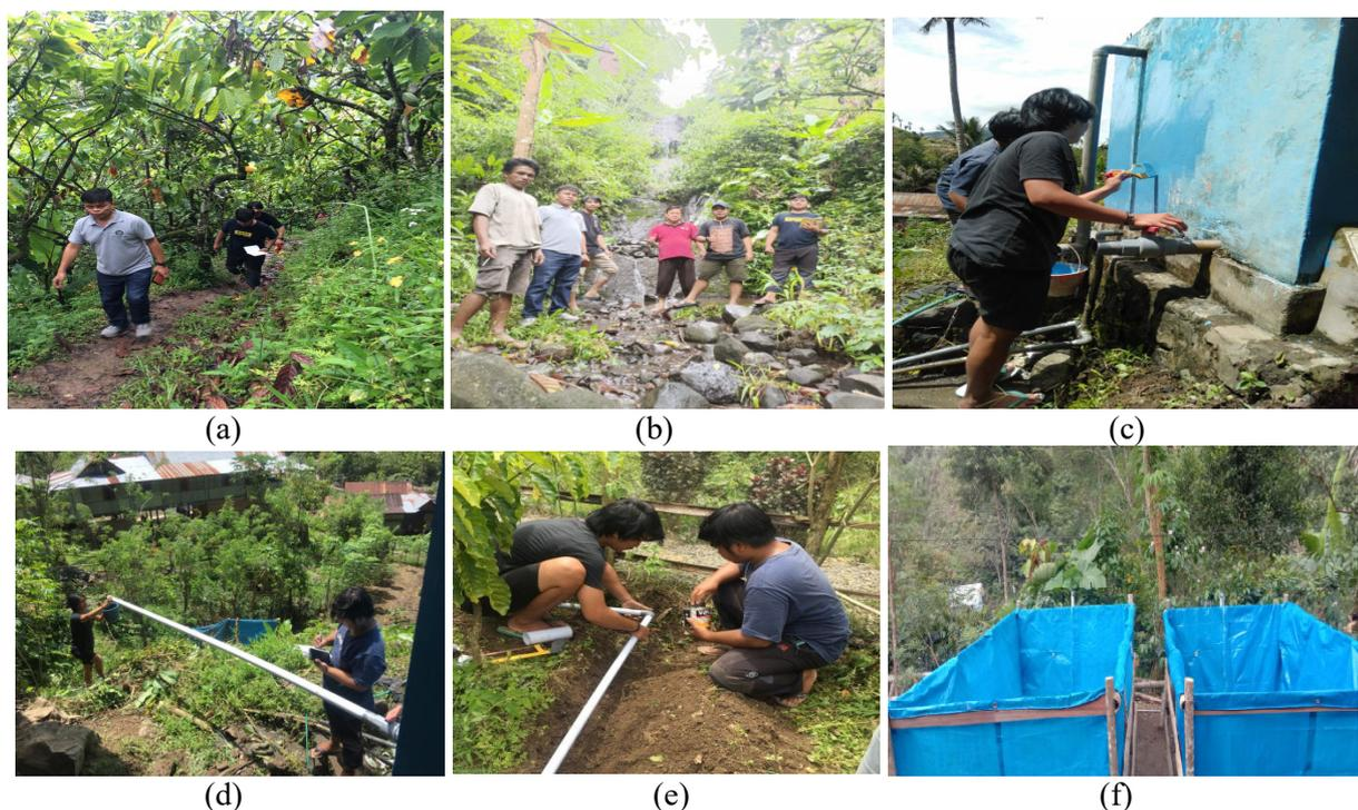
Gambar 3. (a). Jalan menuju sumber air; (b). Lokasi sumber air; (c) Pengecatan bak penampungan; (d) Penyambungan pipa di Dusun Makula'; (e). Penyambungan kerumah warga; (f). Pembuatan kolam terpal
