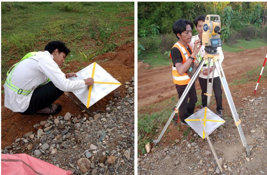
Gambar 3. Pelaksanaan pengukuran poligon menggunakan alat total station
