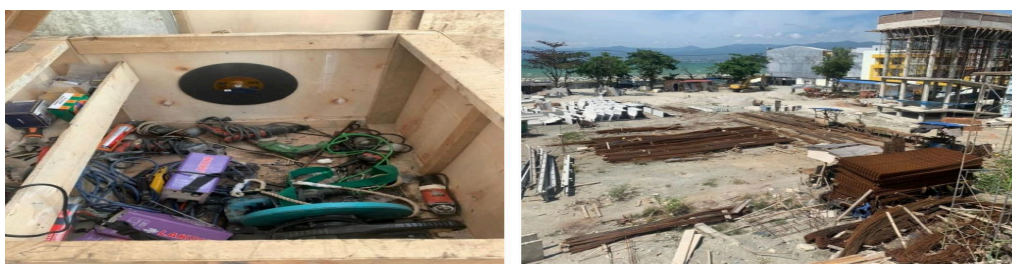
Gambar 4, Kondisi Lingkungan Tempat Kerja Terhadap Keberhasilan Proyek Konstruksi
