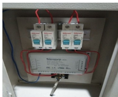
Gambar 7. Pemasangan panel sonoff
