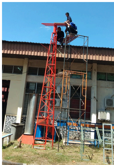
Gambar 2. Pemasangan sel surya
