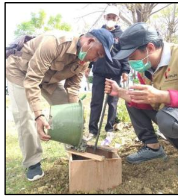
Gambar 3. Tahapan kegiatan pembuatan patok BM di lokasi pantai Kuri Caddi
