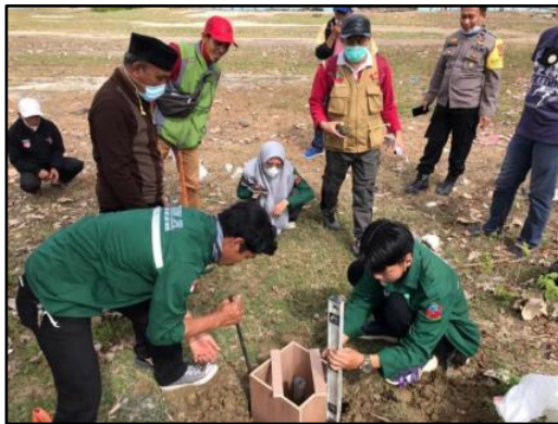
Gambar 3. Tahapan kegiatan pembuatan patok BM di lokasi pantai Kuri Caddi
