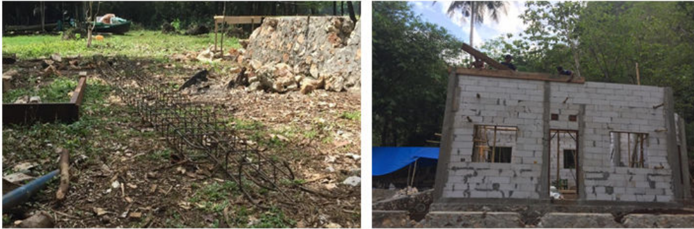
Gambar 5. Pembuatan tulangan ringbalk dan cetakan/bekisting
