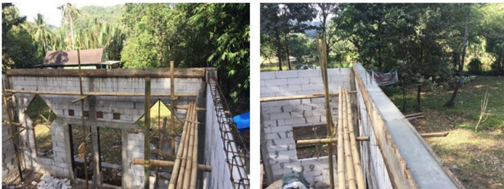
Gambar 5. Pengecoran dan Perawatan Beton
