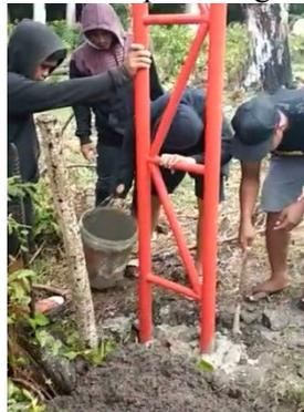
Gambar 5. Pengecoran tiang pada pemasangan gerbang TPU dan papan nama
