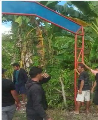
Gambar 4. Pemasangan tiang pada lubang pondasi
