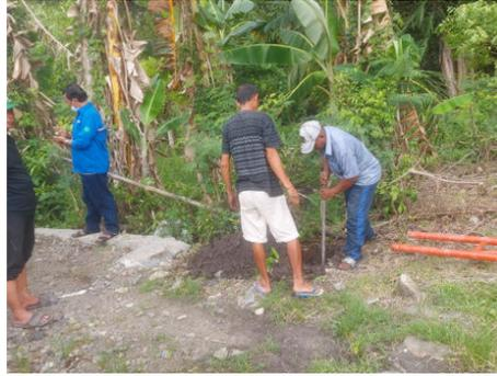
Gambar 3. Penggalian lubang untuk penempatan tiang
