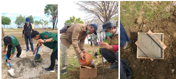
Gambar 4. Pembuatan patok BM di lokasi kawasan pantai kuri caddi
