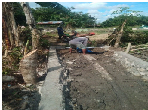
Gambar 5. Pekerjaan timbunan jalan masuk TPU
