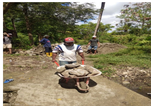
Gambar 2. Pengangkutan Material ke lokasi Pekerjaan
