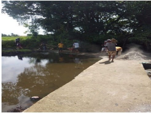
Gambar 3. Pencampuran Spesi untuk pemasangan Pondasi
