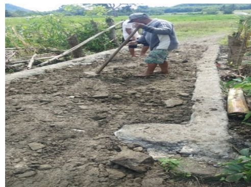
Gambar 6. Meratakan timbunan jalan masuk TPU
