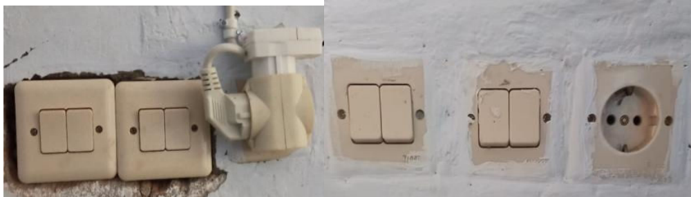
Gambar 2. Saklar dan Stop Kontak Setelah Diperbaiki
