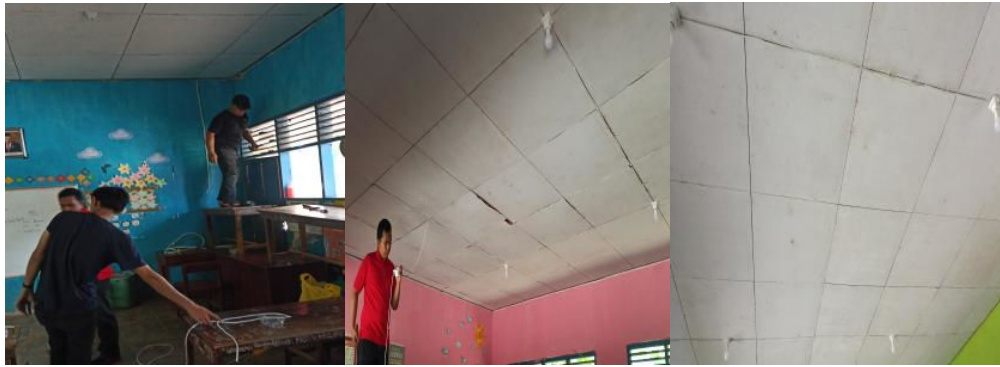
Gambar 7. Pemasangan Instalasi Penerangan
